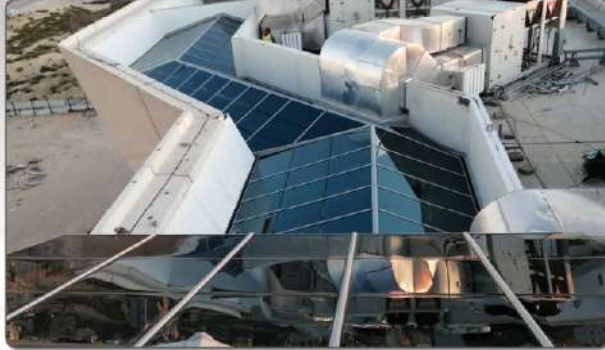
مبنى مكتب وزارة العمل بفرعه بقيق - رأس تنورة
